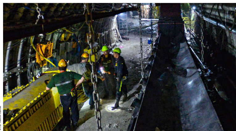
Čím dále od jámy a hlouběji, tím jsou podmínky náročnější.
