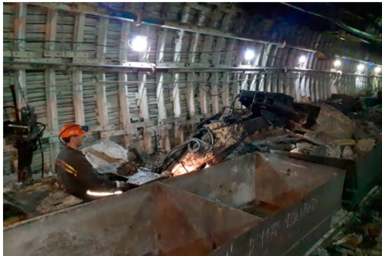
Veškeré práce proběhly za plného provozu.
