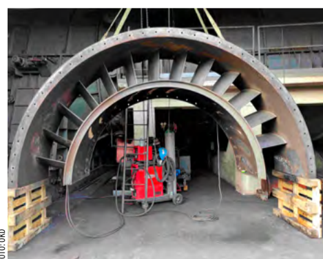
Oprava hlavního ventilátoru na Jihu.
