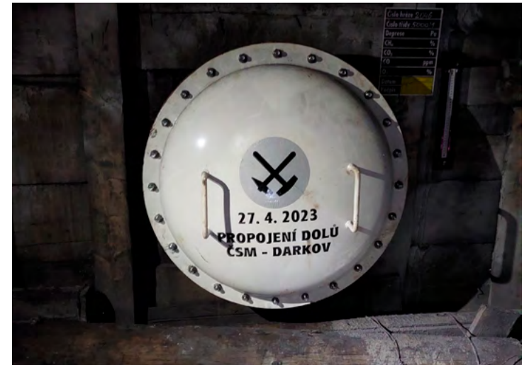
V 10:36 se spojení ČSM - Darkov a zároveň OKD - Diama stalo minulostí. Uzavření zlepší mikroklima v oblasti ČSM, kde se připravují další porubní bloky a usnadní jejich větrání. Také sníží náklady i čas potřebný na údržbu důlních děl.
